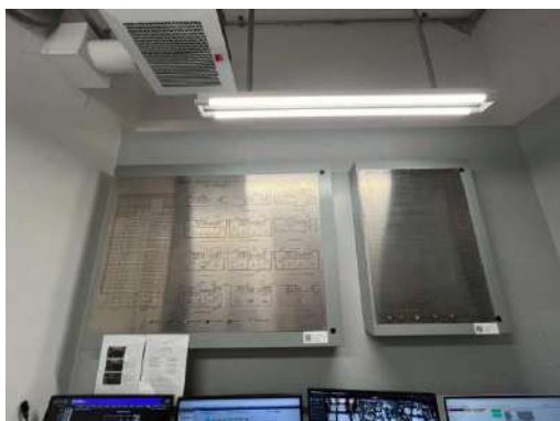
แผงควบคุม Fire Alarm
