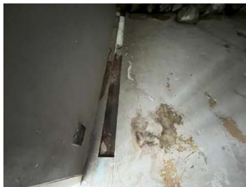
รูปที่ 2-49 ท่อรวบรวมน้ำเสียจากห้องพักขยะรวม
